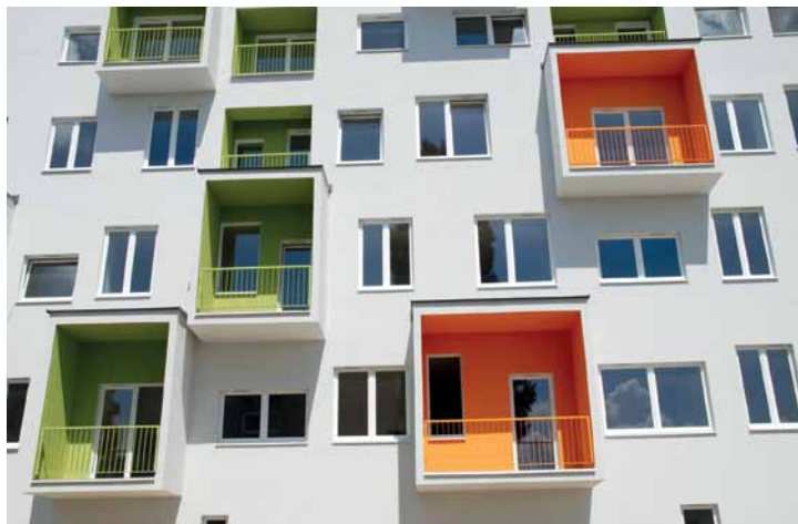
Bytový dom DORNYK v Bratislave
